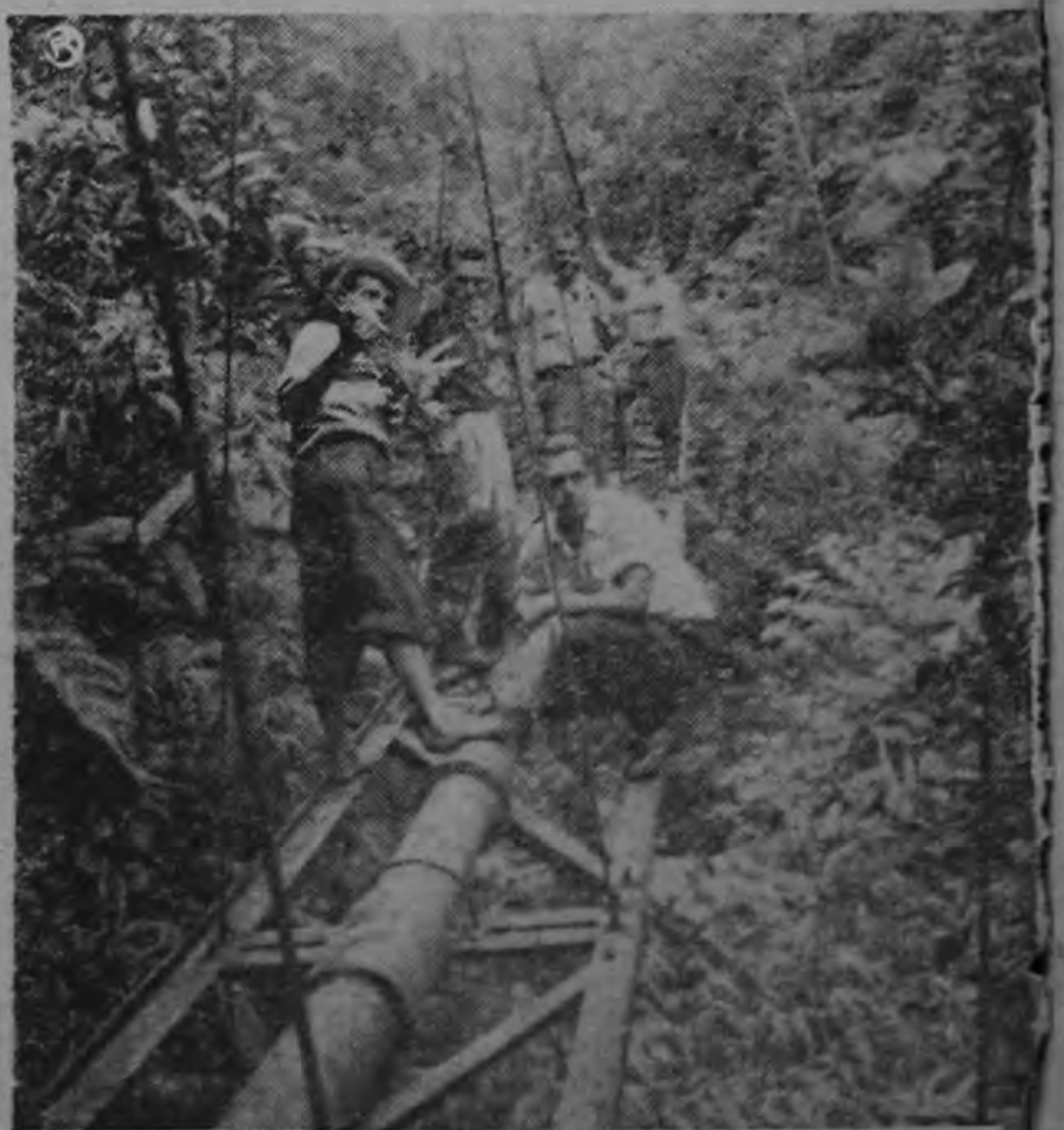
Una cuadrilla de trabajadores municipales instala el tubo en la cañería de Montes de Oca, que hubo de ser sustituido, habérsele destruido el que estaba en servicio, al recibir el impacto de una piedra de tres mil libras.
